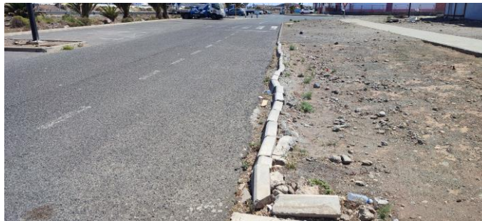
Imagen donde se ilustran los bordillos a reponer
